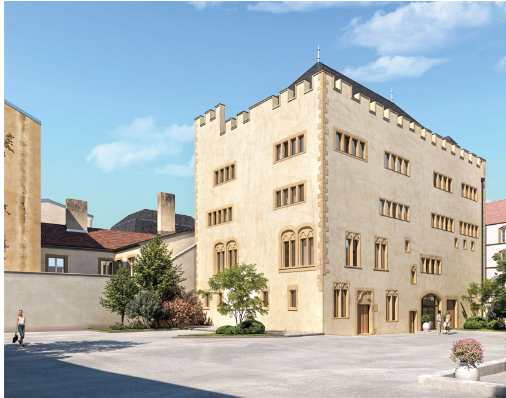
Vue de façade de la Commanderie Saint-Antoine
